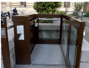
Ascenseur ou monte charge pour les parkings Vinci centre-ville.
