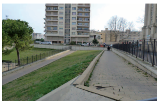
Rampes d'accès pour le Lez.
