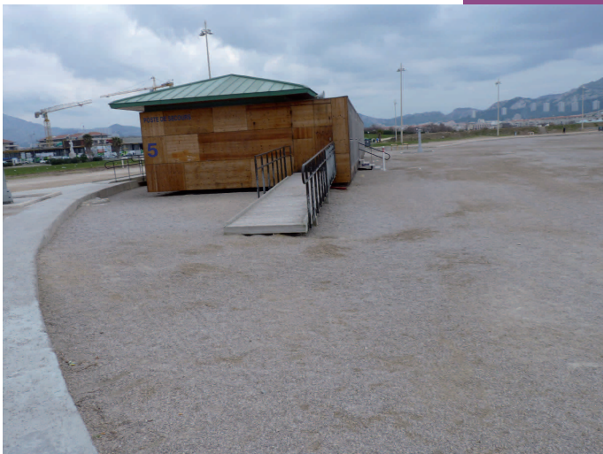
Installation plage du Prado.
