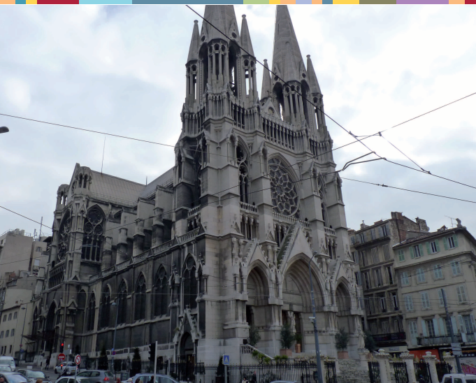
L'église des Réformés, inaccessible.
