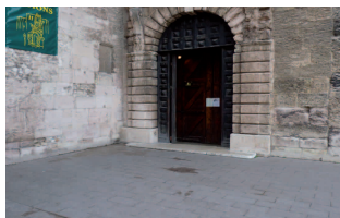
Entrée principale inaccessible.
