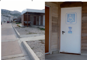
Toilette accessible à la capitainerie.
