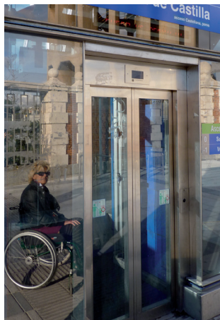
Ascenseurs aux stations accessibles.
