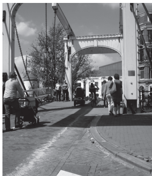
Pont au-dessus d'un canal.
