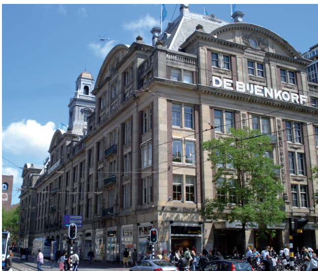
Centre commercial De B'Jenkorf avec toilettes accessibles.
