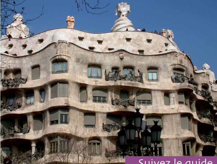
La façade de la Pedrera.
